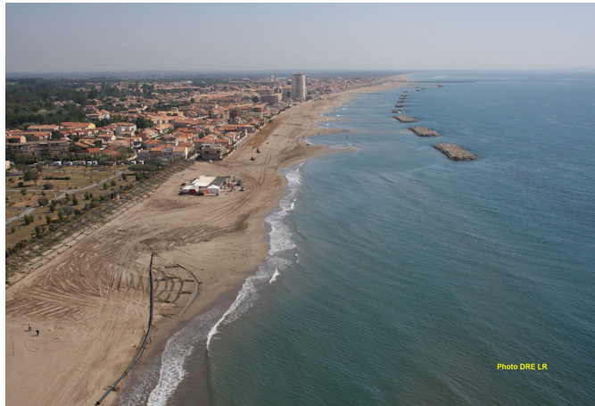
Illustration 9 : Brises-lames à Valras (34) ne se substituant pas au trait de côte (Photo : DREAL LR)
