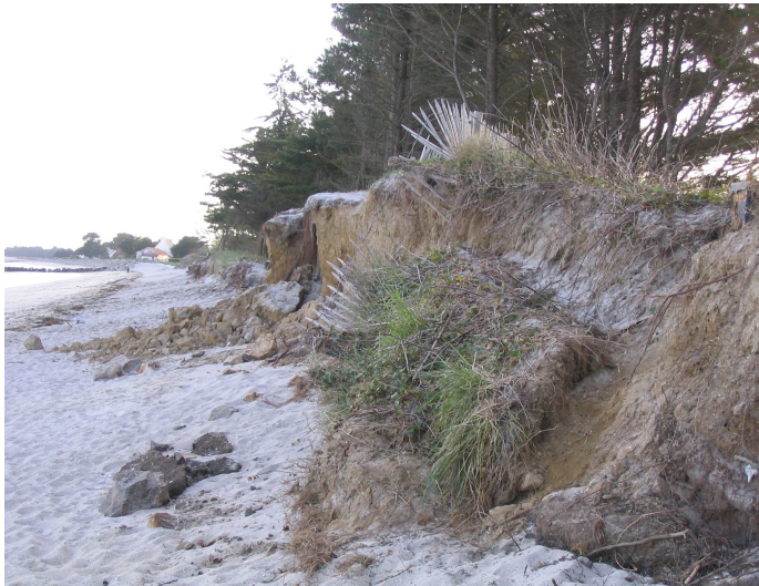
Illustration 2 : Recul du trait de côte dans le sud Finistère (Photo : DDTM 29 - UPR)
