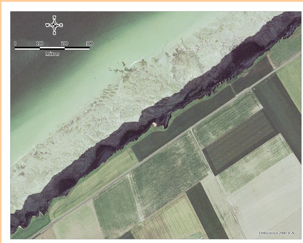
Illustration 24: Découpage du trait de côte selon les principales orientations des discontinuités observées sur site (Source : Ortholittorale 2000).
