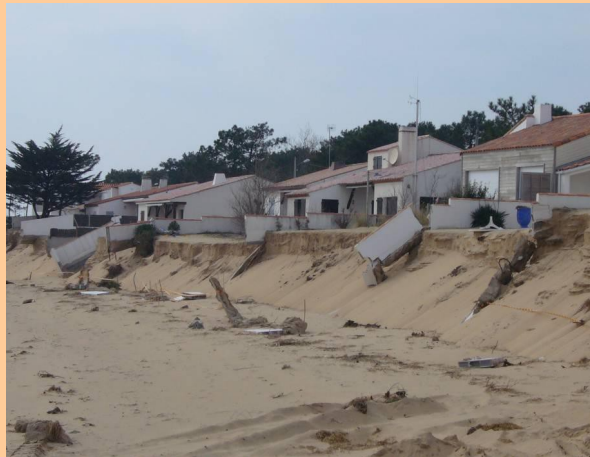
Illustration 18 : Recul exceptionnel de la dune suite à la tempête Xynthia - mars 2010 – La Tranche sur Mer, Vendée (Photo : BRGM)
